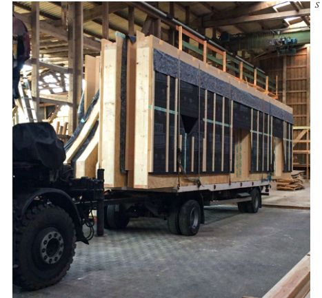
Ein Landarbeiterhaus auf einem Anhänger, fertig zum Transport. September 2016
