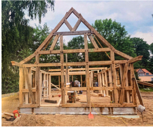
Das Gerippe aus schweren Eichenholzbalken
