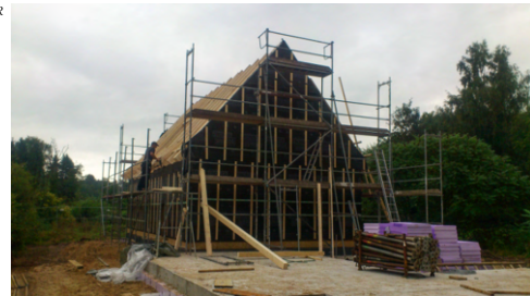
Firma Lorenzen & Fätkenheuer bauen im September 2016
