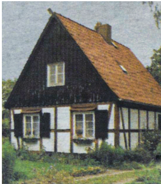
Landarbeiterhaus in der Herrenhausallee - im schlechten Zustand, 1998
