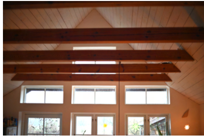
↑ Sichtbares Eichenständergerüst in der alten Scheune.
