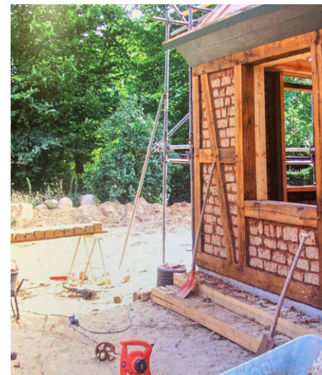
Die getrockneten Steine kommen zwischen die Fachwerkstile.
