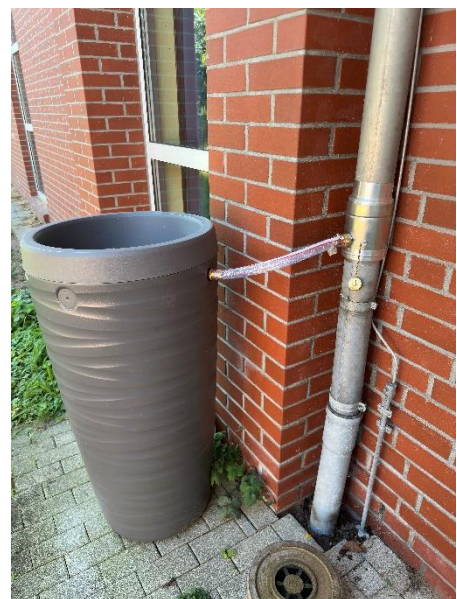
Abb. 14: Eine der neuen Regentonnen an Trakt 1.
